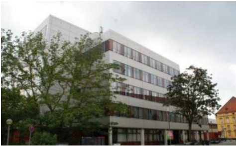
EW-Gebäude (Geb. 15) Seminarstraße 20
