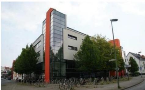
Kolpinggebäude (Geb. 01) Kolpingstr. 7
